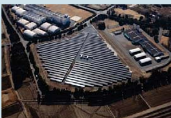
(上) 真壁太陽光発電所
